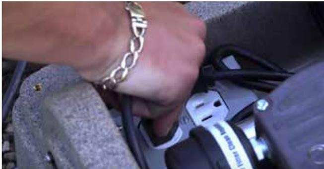
Enchufe los compresores en la salida de control de potencia dentro del gabinete. Asegurar El interruptor de alimentación está en la posición "ON". Conecte la salida de control de alimentación a una toma de corriente GFCI.
